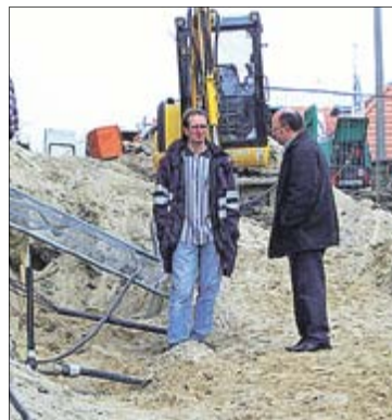
Die Jahrtausendwende war eine Zeit vieler neuer Technologien. Hier wurde eine Erdgasleitung in Spandowerhagen eingepflügt.
