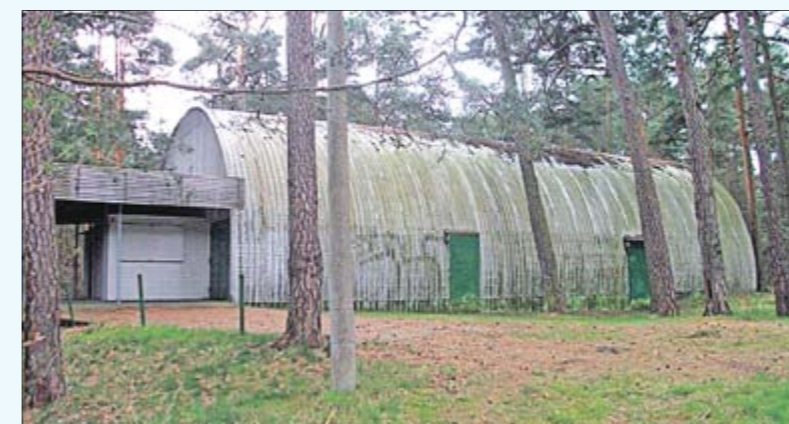
Kein russischer Flugzeughangar, sondern das Blechkino. Zu DDR-Zeiten war es ein Highlight. 2012 wurde es abgerissen.
