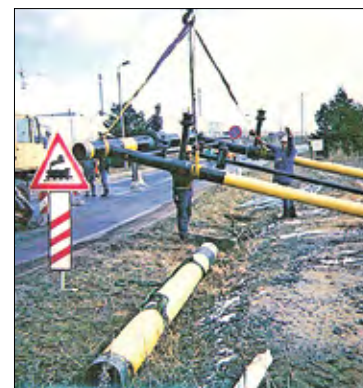
Der Anschluss der Energiewerke Nord war einer der größten Meilensteine in der Entwicklung der GVP.
