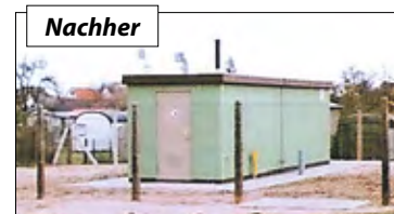
... ein Beispiel ist die Druckregelanlage in Wolgast/Tannenkamp.
