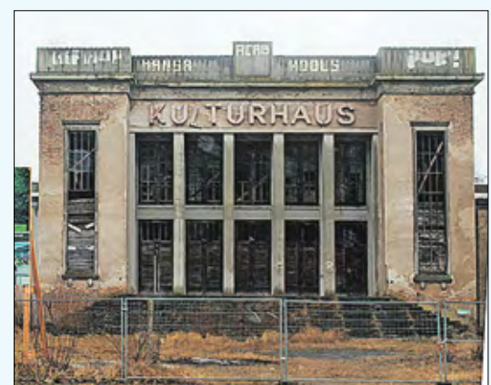
Das Kulturhaus wurde 1953 bis 1957 errichtet, steht unter Denkmalschutz und soll bereits nächstes Jahr wieder in neuem Glanz erstrahlen. Foto: SPARE-PR/Kuska
